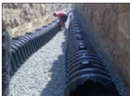
Tranchée d'infiltration (tunnels GRAF) Galati (Roumanie)
