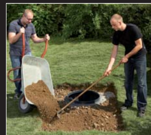
Les photos ci-dessus représentent l'installation d'une cuve Platine® 1600 L.
